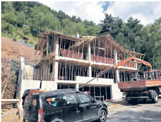
Construcció en general.
