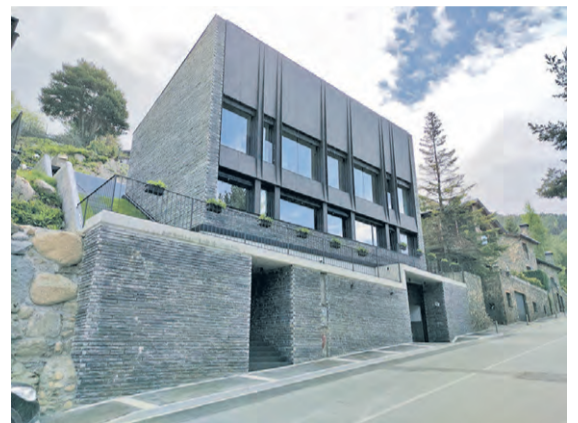
Construcció de Passivhaus.
