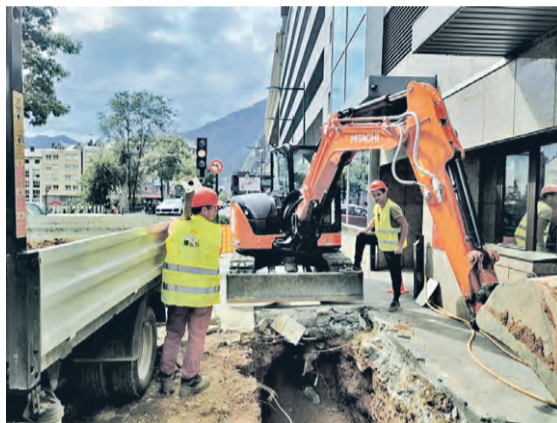
Treballs amb excavadora.
