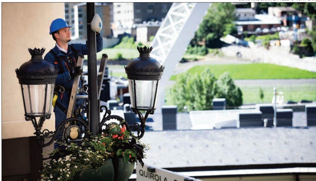
Un operari instal·la un dels comptadors d'aigua del nou sistema de telelectura.
