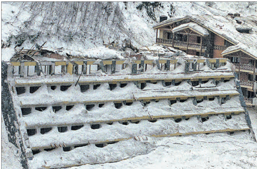
Un dels edificis afectats per les allaus de neu.
