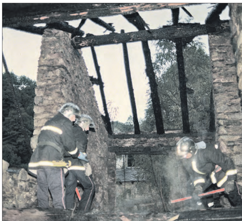
Els bombers actuen en un dels edificis afectats.
