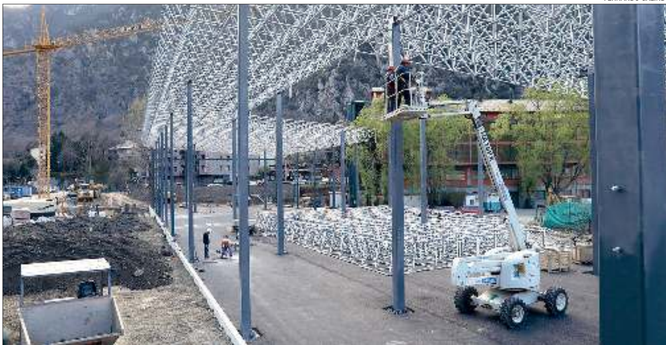
CONSTRUCCIÓ DE LA PISTA CENTRAL del nou complex de tennis, pàdel i escola Principàdel.
