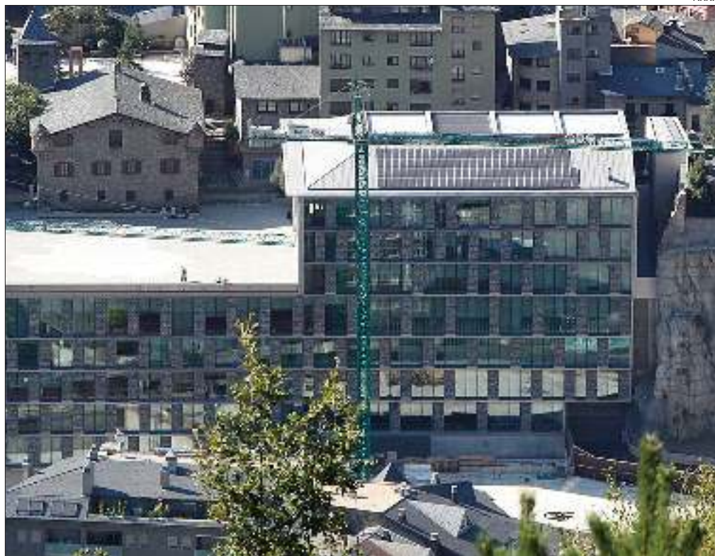
PLAQUES SOLARS AL SOSTRE del nou edifici del parlament, al costat de Casa de la Vall.
